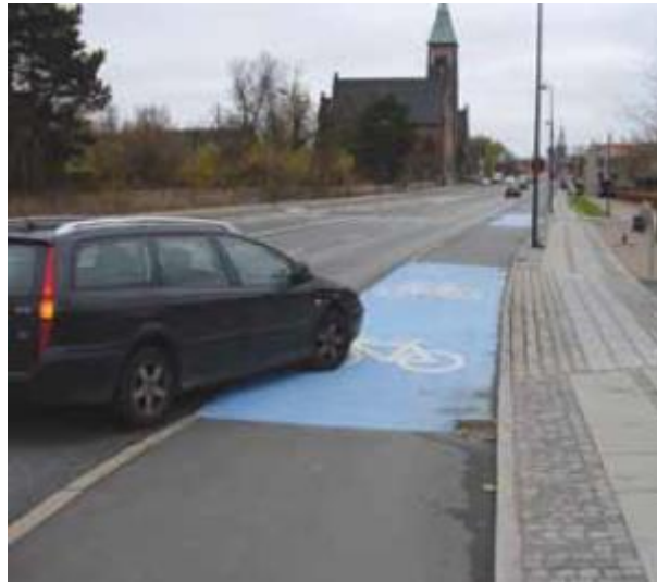
2. irudia: Seinaleztapen horizontala, kontrasteko puntura bidez, elkargune baterako (Iturria: Collection of Cycle concepts 2012- Cycling Embassy of Denmark)
