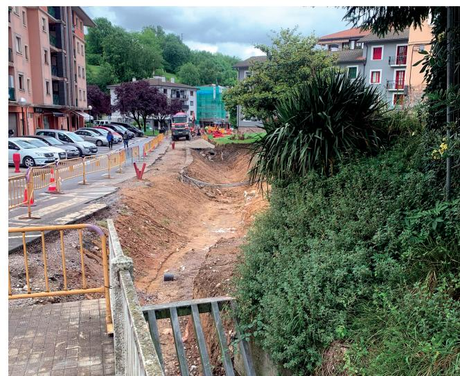
El objetivo del proyecto es solucionar, en un tramo, la insuficiencia de sección del tramo subterráneo del río Olazar, mediante la naturalización del cauce, excavando su sección al aire libre y mejorando la capacidad hidráulica del tramo, así como la recuperación ambiental del río en la medida de lo posible.
